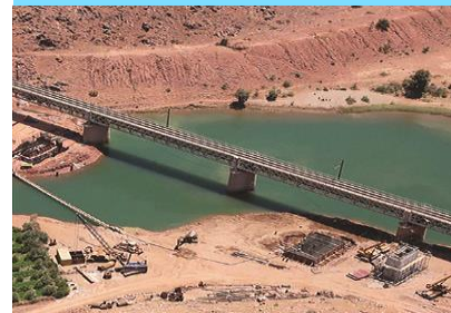
Doublement complet Casablanca - Marrakech
